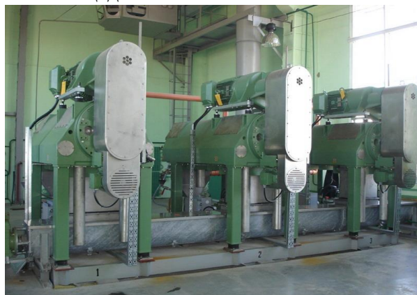
Рис. 1. Декантеры производства фирмы «Вестфалия Сепаратор АГ» (Германия), установленные в цехе механического обезвоживания осадка на Городских очистных сооружениях водоотведение № 2 (Безлюдовские)
