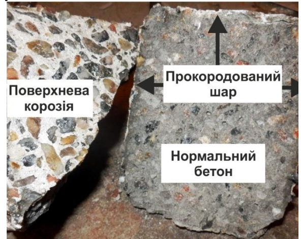
а) зразки кубів б) зразки балочки Рис. 4. Вигляд зразків бетону після випробування на розтяг
