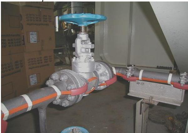
Рис. 3. Общий вид водопроводной трубы с вентилем, расположенной в закрытом неотапливаемом помещении и защищенной от промерзания гибкой электрической нагревательной лентой.
