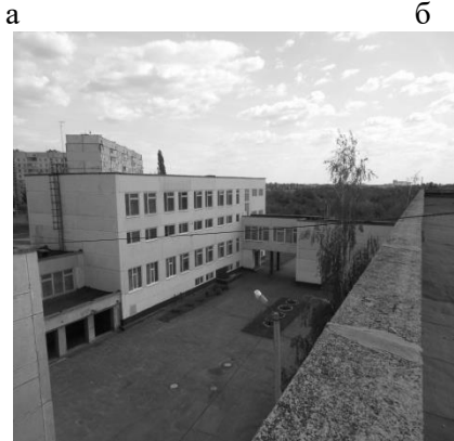
Рис. 1. Загальний вигляд об'єкта досліджень: а – школа, б – басейн, в – прибудова
