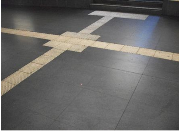
Рис. 5. Попереджувальна тактильна смуга. Підземний перехід
