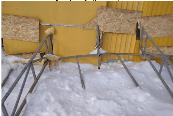
Рис. 4. Конструктивное решение опирания ферм
