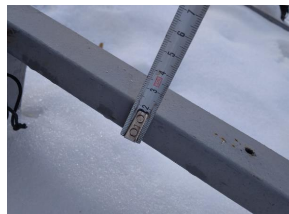
Рис. 2. Размеры поперечного сечения стержней фермы
