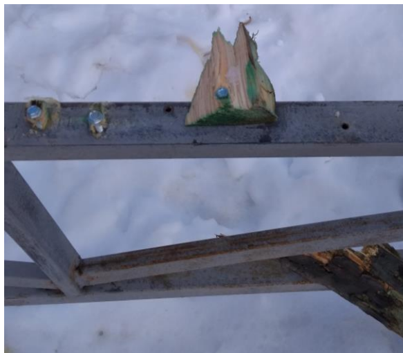
Рис. 5. Фрагменты дощатого настила и элементов крепления по верхним поясам ферм
