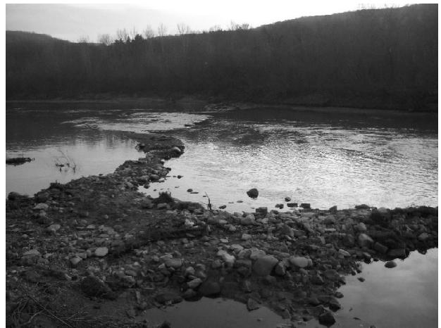
Рис.1. Оголене фільтраційне обсіпання водозабірних дрен
