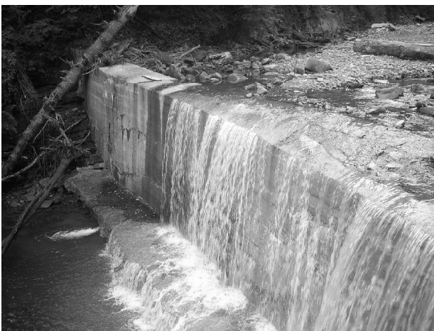
Рис.2. Бетонна гребля в руслі р.Жонка
