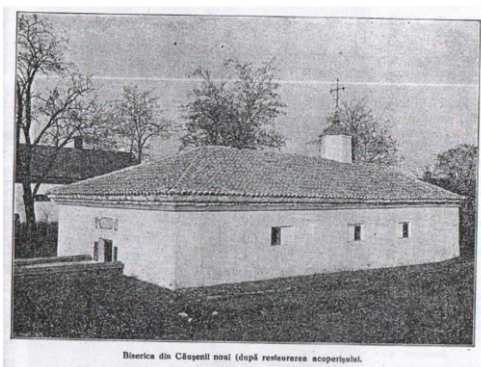
Biserica din Căușenii noi (după restaurarea acoperișului).
