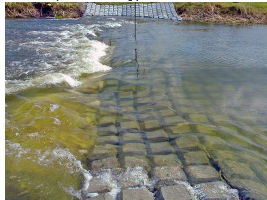
Рисунок 6 – Укладений на дно річки трубопровід, захищений універсальними гнучкими захисними бетонними матами
