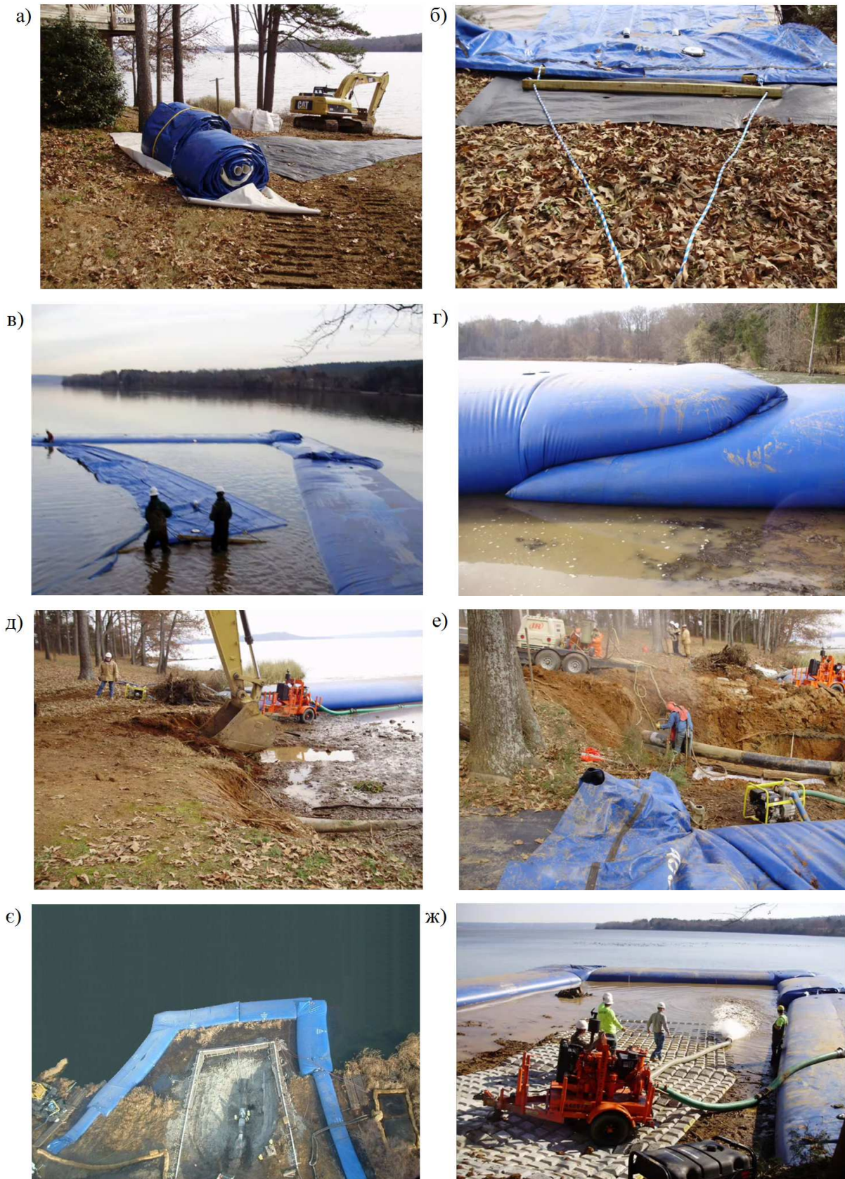
а) – доставлена до місця монтажу система Aqua-Barrier в рулонах; б) – прикріплені до підіймальної петлі канати; в) – розкладання за периметром робочого простору системи Aqua-Barrier; г) – з'єднання секцій системи Aqua-Barrier; д) – розкопування дефектної ділянки трубопроводу; е) – ремонт трубопроводу; ж) – заповнення робочого простору водою
