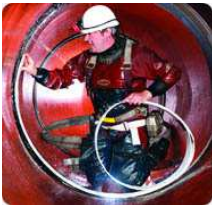
Рисунок 10 – Закріплення муфти до внутрішньої поверхні трубопроводу
