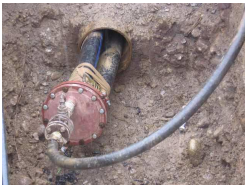
Рисунок 3 – Розширення С-подібного лайнера тиском пари
