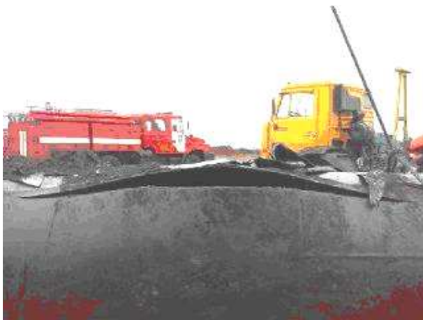
Рисунок 1 – Повздовжній розрив труби діаметром 530 мм магістрального нафтопроводу “Дружба” [7]
