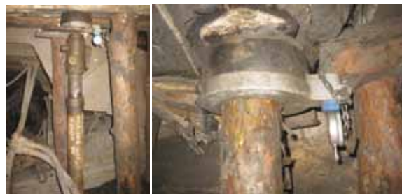
Рис. 8. Измерение нагрузки, действующей на охранное сооружение
