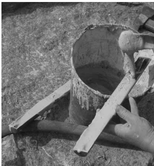
Рис. 5. Заливка НРС в патроны
