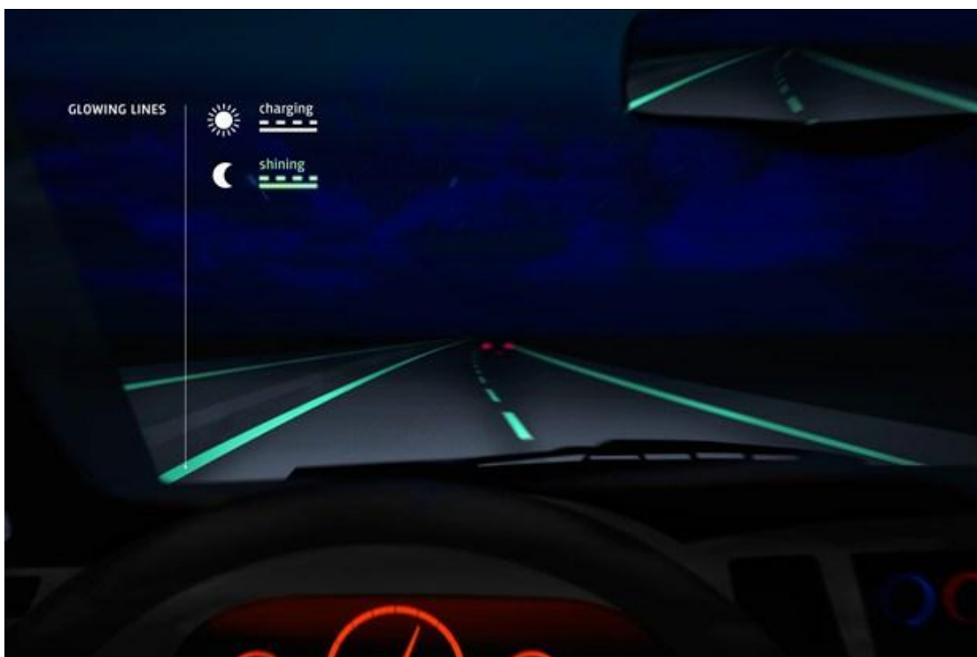
Рис. 2. Розмітка накопичує світло вдень і віддає світло вночі*
