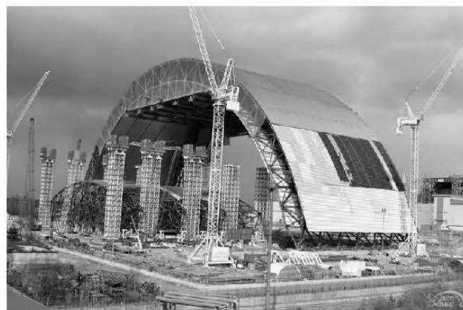
Рис. 10. Схема Объекта «Укрытие» и Нового Безопасного Конфайнмента в поперечном сечении (а) и фото частично собранного НБК (октябрь 2014 г.) (б: 1 – мащитал, 2 – разрушенный реактор, 3 – Объект «Укрытие», 4 – основной объем НБК, 5 – стальные конструкции и кольцевое пространство Арки НБК.
