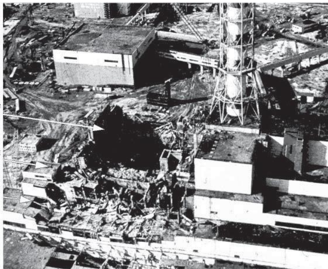
Рис. 1. Разрушенный 4-ый блок ЧАЭС (май 1986 г.).
