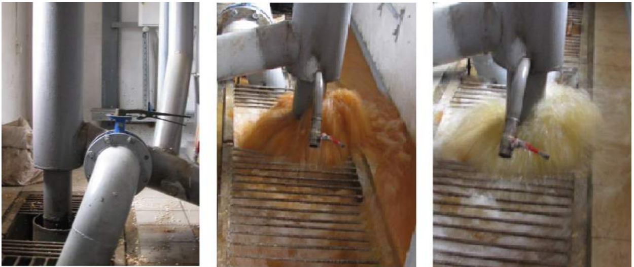
Рис. 5. Система гідроавтоматичної промивки – сифон «труба в трубі»: а – в нормальному режимі фільтрування; б – на початку промивки; в – в кінці промивки
