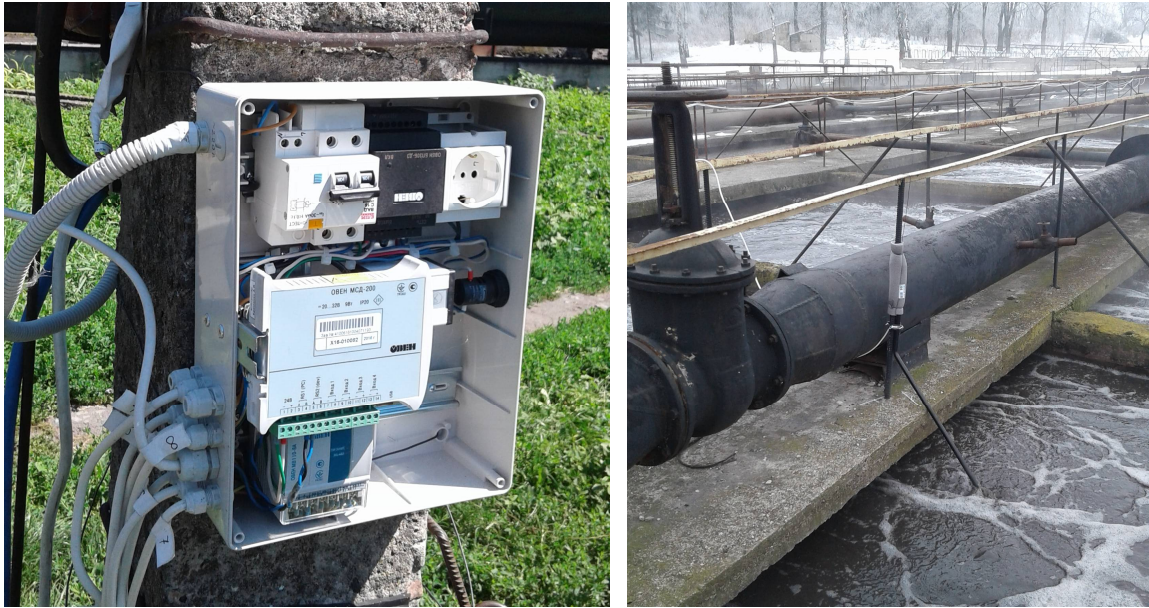
Рис. 1. Зовнішній вигляд системи автоматизованого вимірювання температури стічної води, активного мулу та суміші стічної води та активного мулу.
