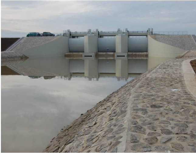
Фото 1. Водозабірна споруда протипаводкової акумулюючої ємкості «Циганд», Угорщина, 2008
