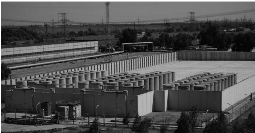
Рис. 1. Сухе контейнерне сховище відпрацьованого ядерного палива Запорізької АЕС.
