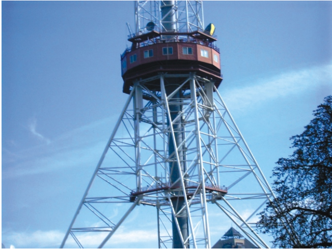
Рис. 4. Нижнее техническое здание и соединение ствола с базой башни
