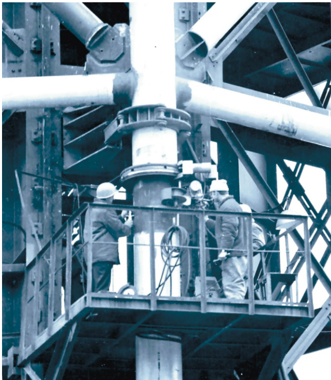
Рис. 1. Откидная монтажная площадка для выполнения автоматической сварки
