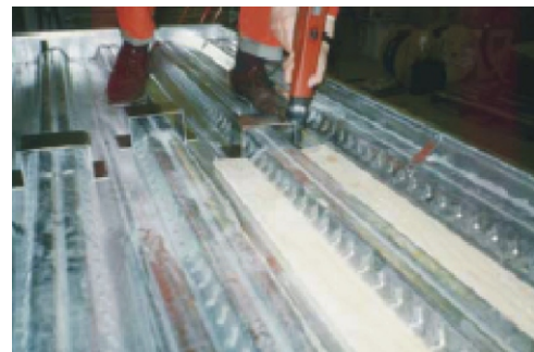
Рис. 11. Монтаж анкерів до СПН
