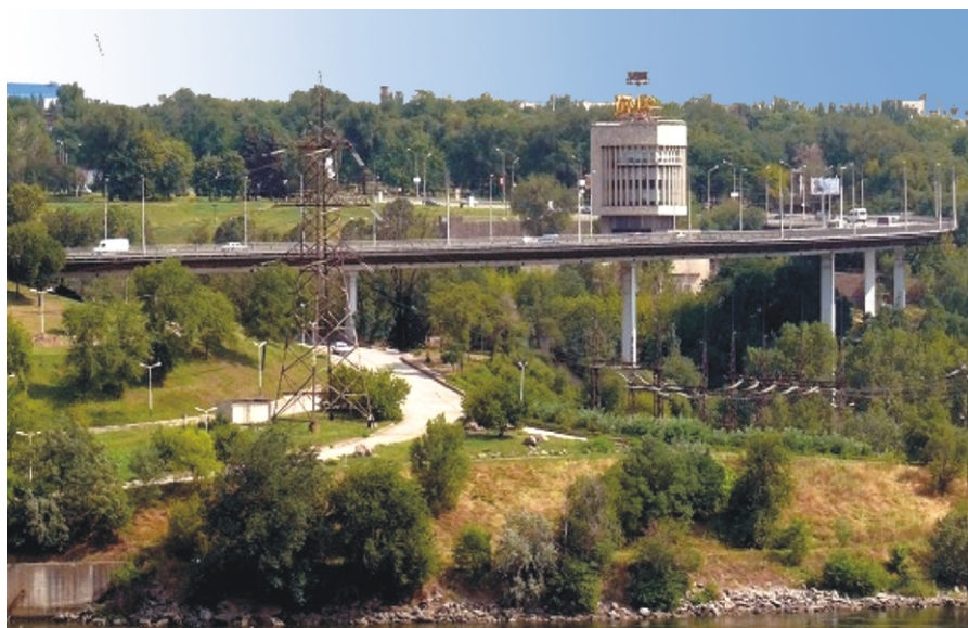
Рис. 1. Естакада над шлюзами мостового переходу через греблю ДніпроГЕС
