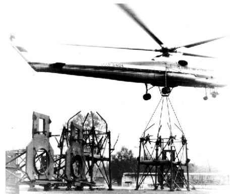
Рис. 5. Строповка канатов для подъема секции
