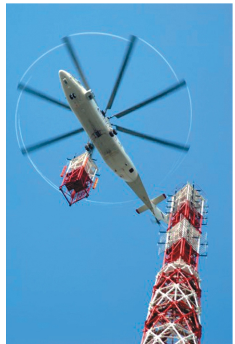
Рис. 1. Возведение структурной башни высотой 258 м с помощью вертолета МИ-26Т
