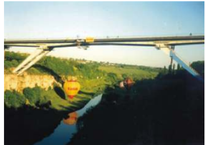
Суцільнозварний міст через р. Смотрич, м. Кам'янець-Подільський
