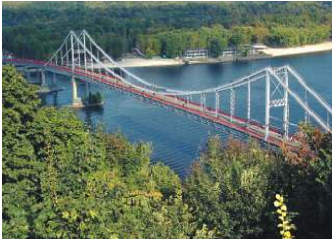
Пішохідний міст через р. Дніпро на Труханів острів, м. Київ
