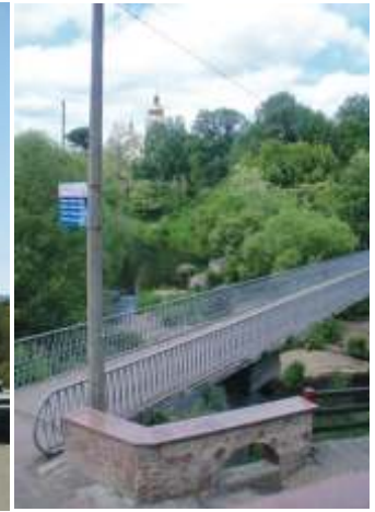
Пішохідний міст через р. Уж, м. Коростень
