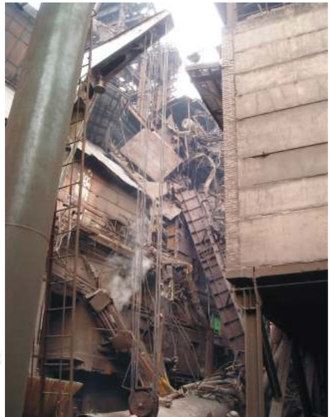
Рис. 3. Доменная печь № 3 после аварии
