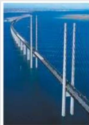
Зресуннский мост г. Мальмо, Швеция – г. Копенгаген, Дания
