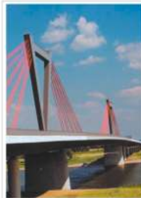
Мост Ильверич г. Дюссельдорф, Германия
