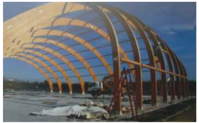
Рис. 4. Момент строительства здания
