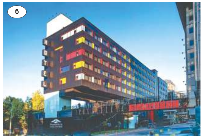
Рис. 2. Завод «Більшовик»: а – адміністративний корпус; б – ТРЦ «Більшовик» після реконструкції виробничих цехів
