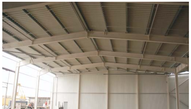
Профнастил Т40, смонтированный в прогонной схеме при шаге Z-прогонов 1750 мм
