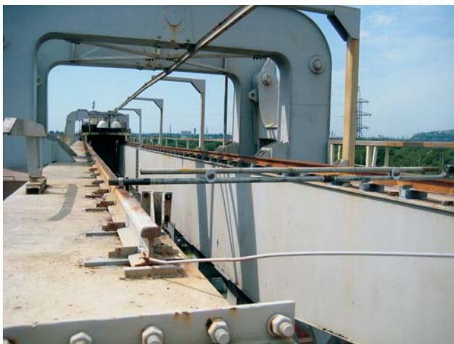
Рис. 2. Установка рельсов на подкладках (сторона полумоста, верхний пояс которого ниже на 60 мм)
