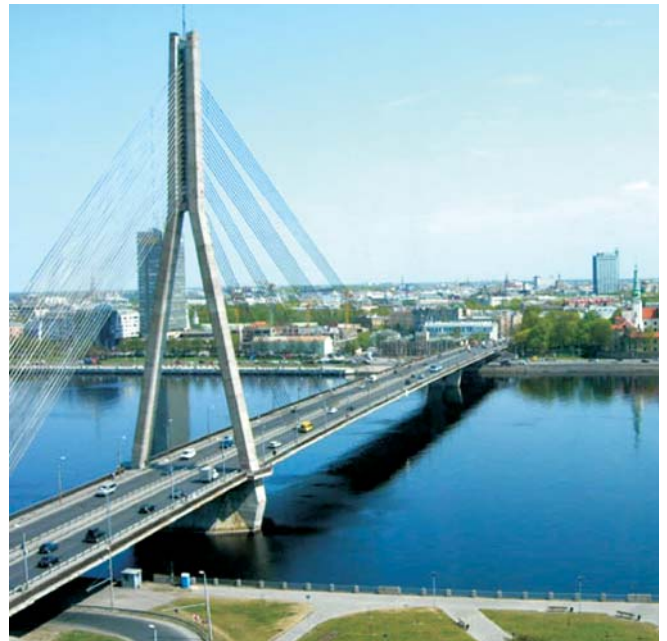
Рис. 1. Автодорожный вантовый мост через р. Даугава в г. Риге. Автор проекта Г.Б. Фукс (ПАО «Киевсоюздорпроект»)
