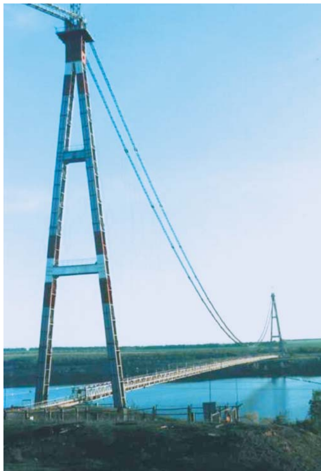
Рис. 1. Висячий мост через р. Днепр на трассе аммиакопровода Тольятти–Одесса
