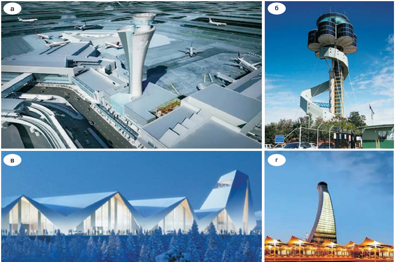
Рис. 4. Будівлі КДП та АДВ в аеропортах:
