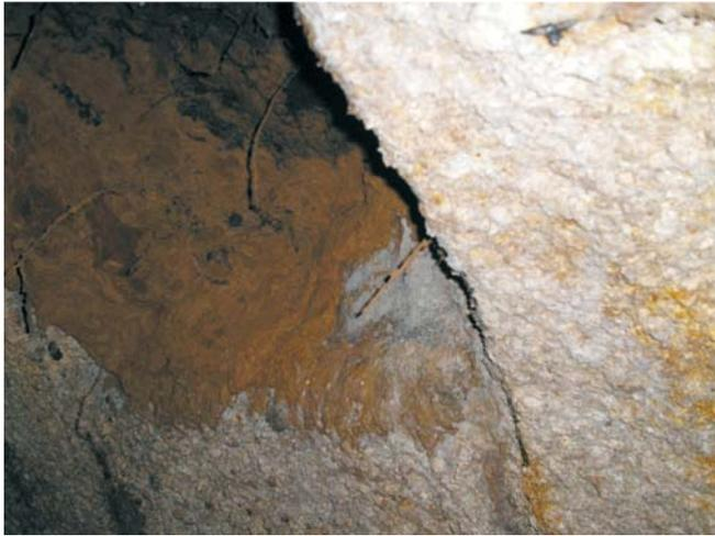
Рис. 1. Разрушенный свод канализационного тоннеля
