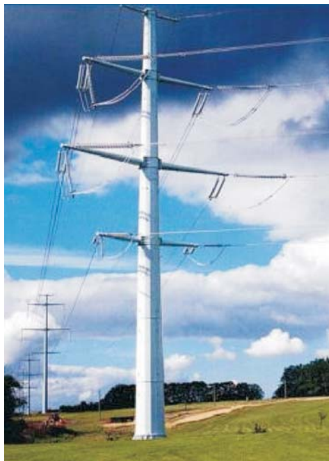
Рис. 1. Опора на основе МГС ВЛ 220 кВ с перспективой модификации в трубобетонную
