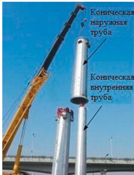
Рис. 4. Монтаж трубобетонной опоры с двойной оболочкой (Норвегия)
