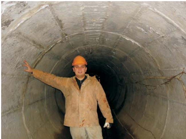
Рис. 4. Загальний вигляд головного дублюючого каналізаційного тунелю
