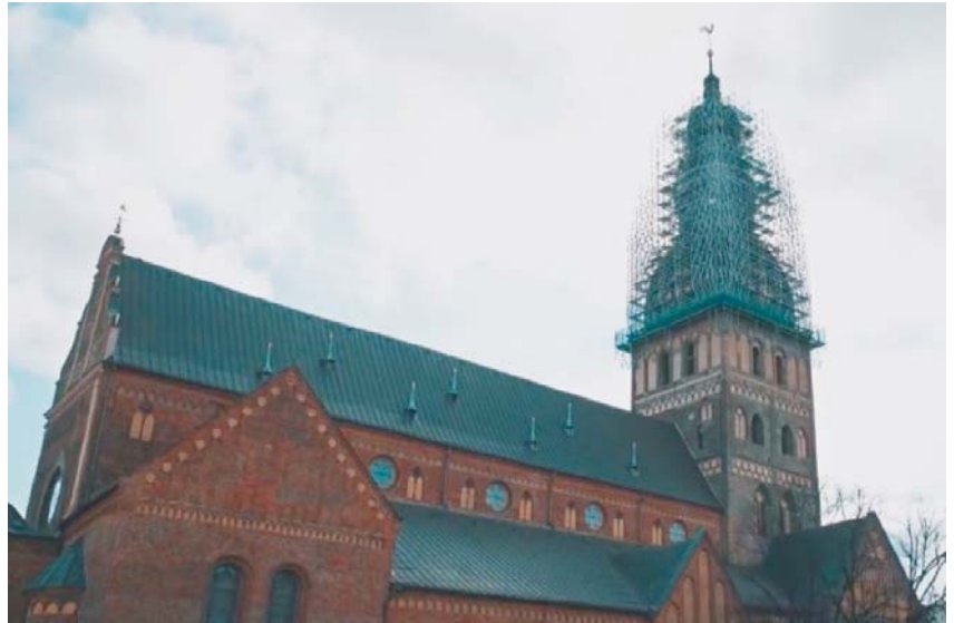
Рис. 2. Реставрация башни рижского Домского собора (Латвия, 2015 г.)
