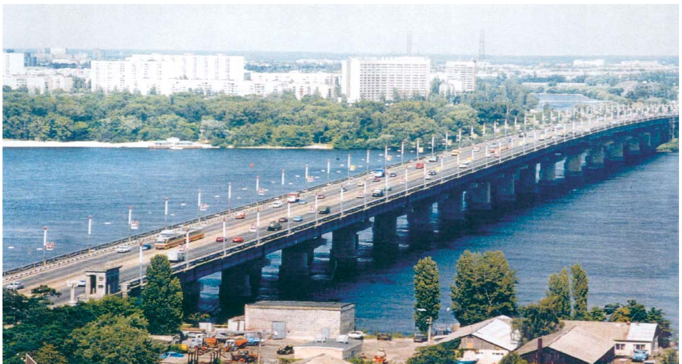
Рис. 1. Загальний вигляд моста ім. Є.О. Патона
