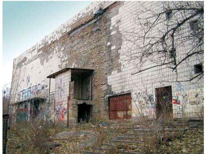
Рис. 2. Вигляд кладки стіни фасаду по осях 10–1
