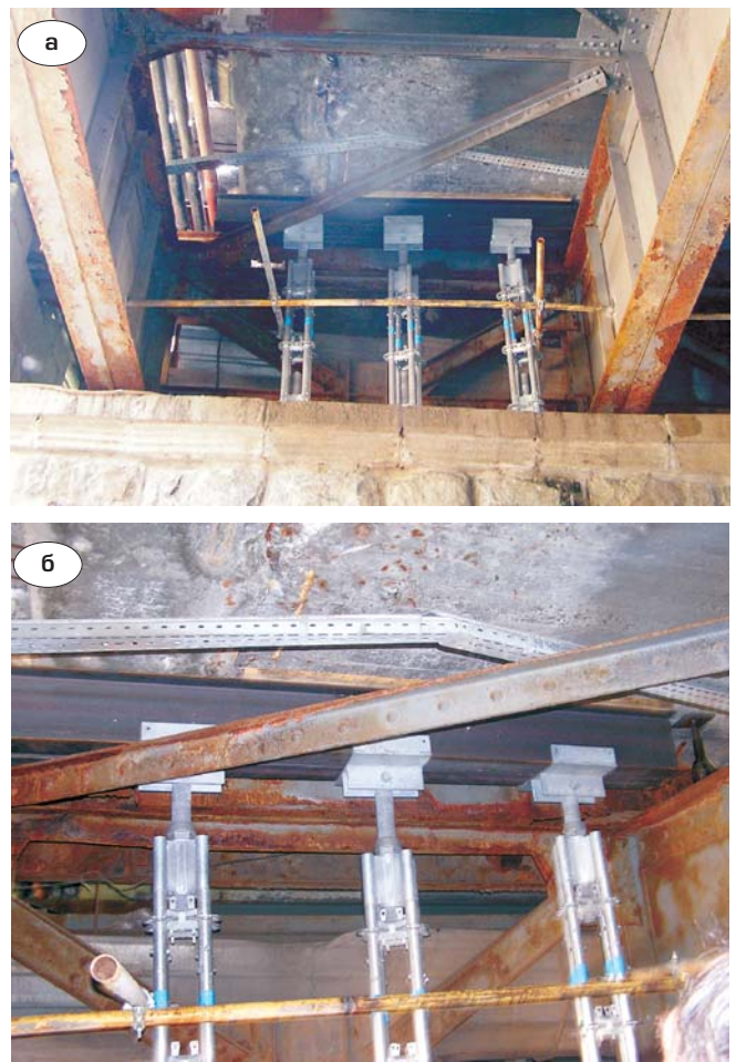
Рис. 5. Тимчасові додаткові металеві балки, обперті на колони підвищеного навантаження: а – загальний вигляд; б – вузол обпірання
