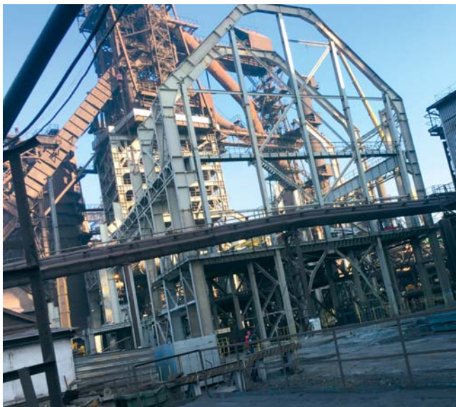
Рис. 4. Монтаж металлоконструкций здания литейного двора ДПЗ «ЧАО Азовсталь»
