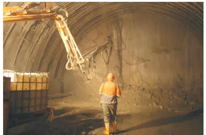
Рис. 4. Проходка калотты. Нанесение набрызгбетона на контур выработки и лоб забоя
