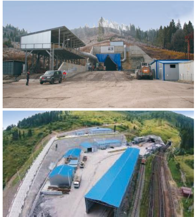
Рис. 1. Будівельна площадка Східного порталі
