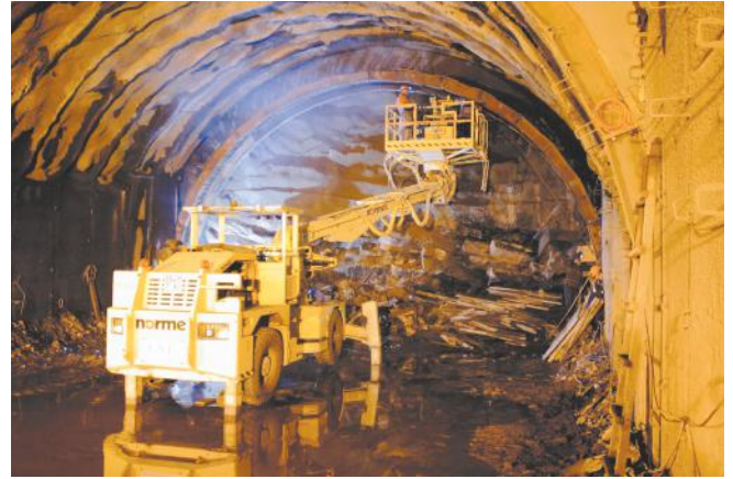
Рис. 3. Проходка калотты. Установка арок временной крепи
