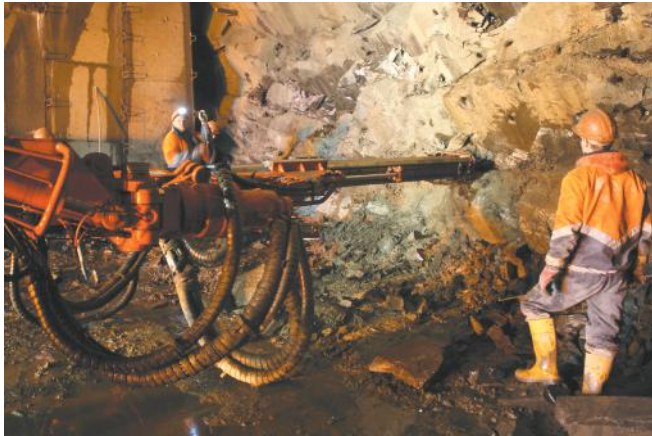
Рис. 2. Проходка калотты. Выполнение буровзрывных работ. Бурение шпуров
