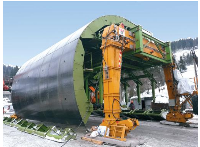
Рис. 5. Смонтированная передвижная опалубка на Восточном портале
