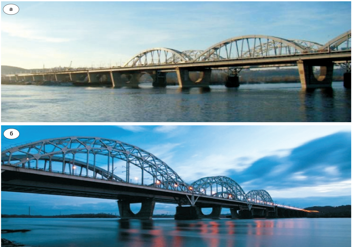
Рис. 1. Загальний вигляд Дарницького залізнично-автомобільного моста через р. Дніпро у м. Києві: а – вдень; б – вночі
