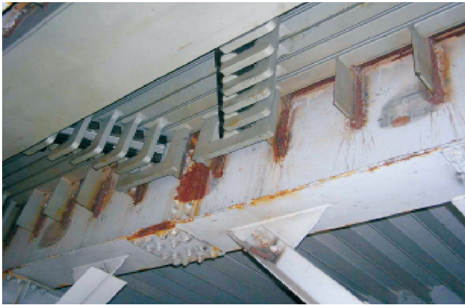
Рис. 9. Поверхнева корозія поперечних балок внаслідок термічного впливу зварювання
