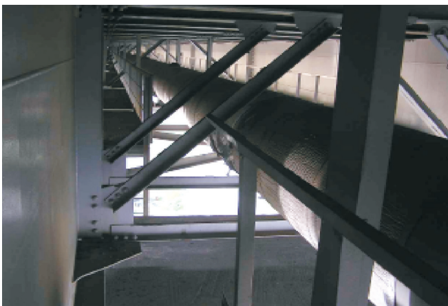
Рис. 10. Відсутні ділянки оглядових ходів
