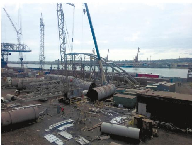
Рис. 4. Сборка арочного пролетного строения на строительной площадке
