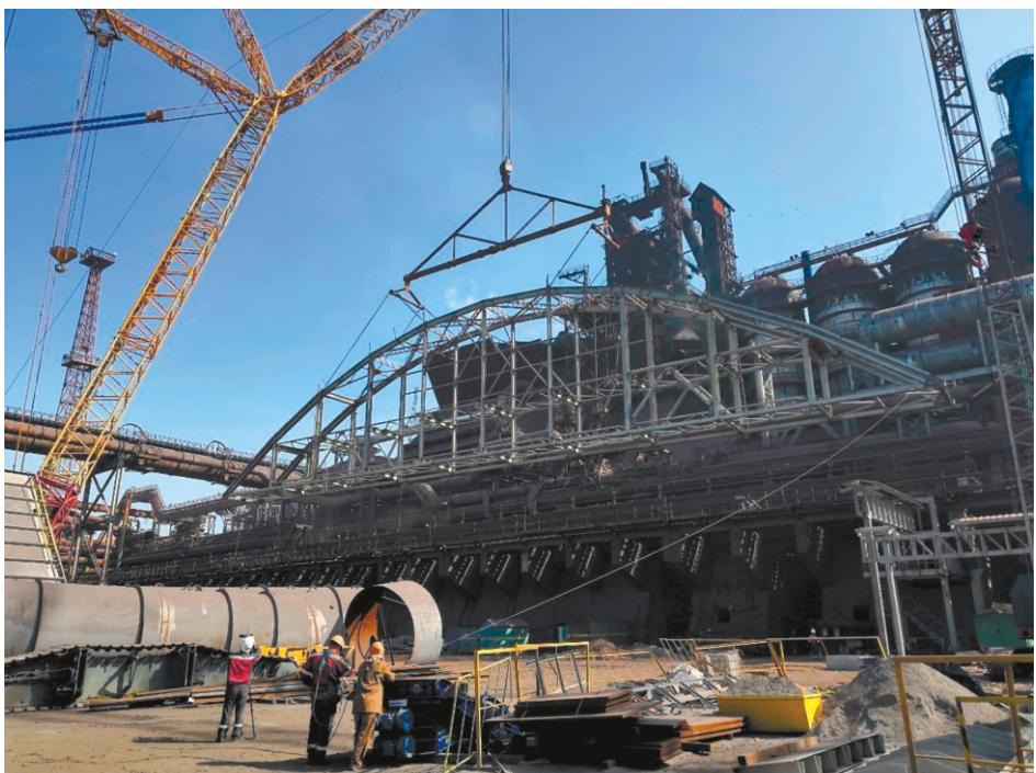
Рис. 5. Монтаж арочного пролетного строения
