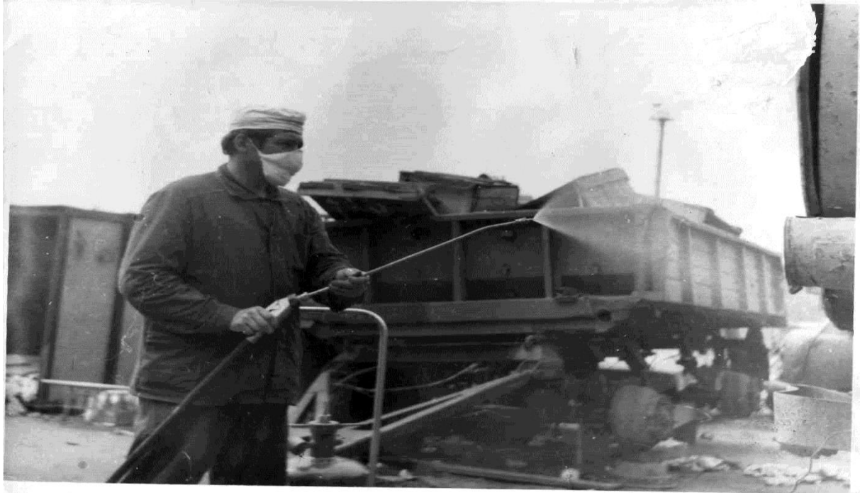
Рисунок 4 – Фіксація радіоактивного пилу плівкоутворюючою речовиною за допомогою БАГа під час ліквідації аварії на ЧАЕС.
