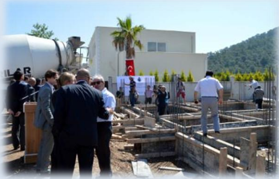
Момент заливки фундаменту будівлі Наукового центру підводної археології в Кемері.
