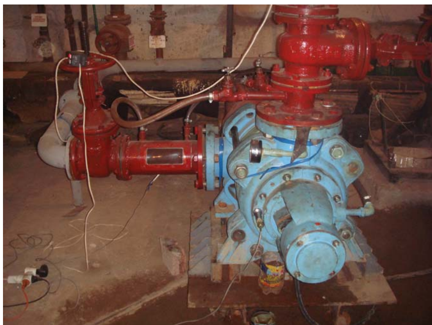
Рис. 2. Термодинамический многосекционный агрегат большой мощности на теплоцентрали одной из школ Украины. Вид на узел генерации тепла и вакуумирующую систему
