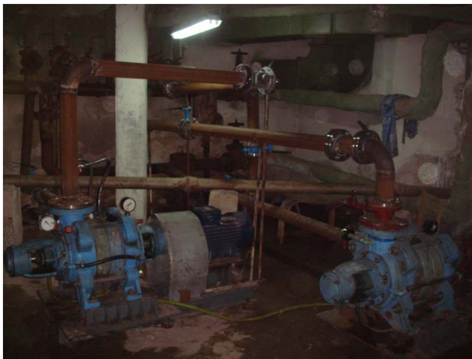
Рис. 4. Комплекс термодинамических многосекционных агрегатов при их совместной работе на сеть в теплоцентрали одного из лечебно-профилактических пансионатов Украины. Компоновка комплекса при параллельной коммутации трех- и четырех-ступенчатых машин на нагнетательный трубопровод
