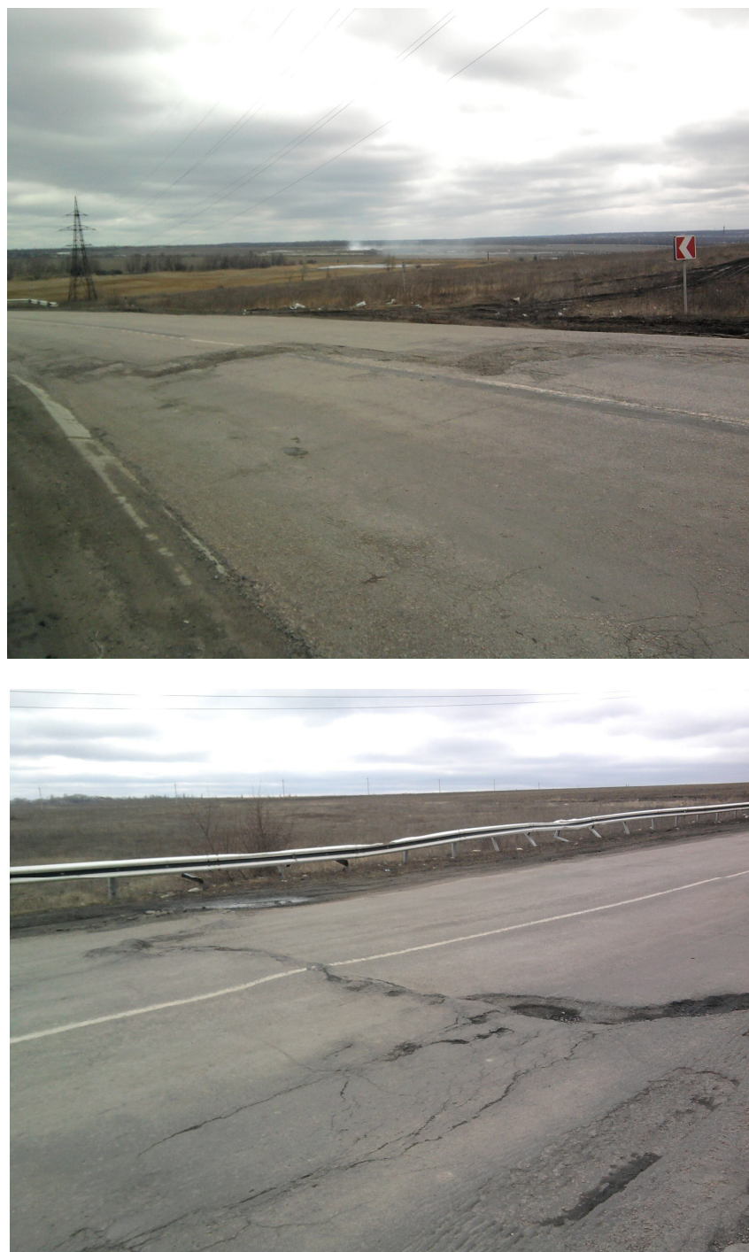
Рис. 14. Результаты подработки трассы Донецк-Ростов
